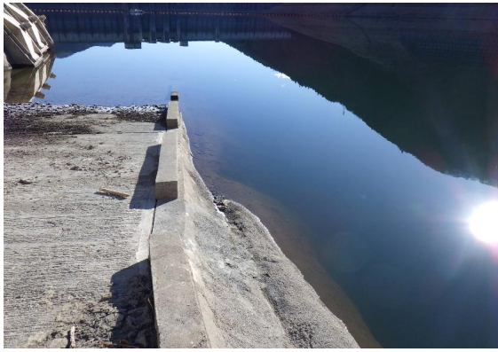
ダム左岸斜路 船舶搬出・搬入作業場所
